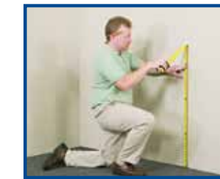
1. Marque las paredes
